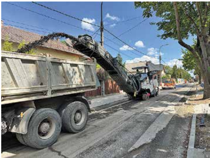
Látványos aszfaltmarás a Szent Korona utcában
