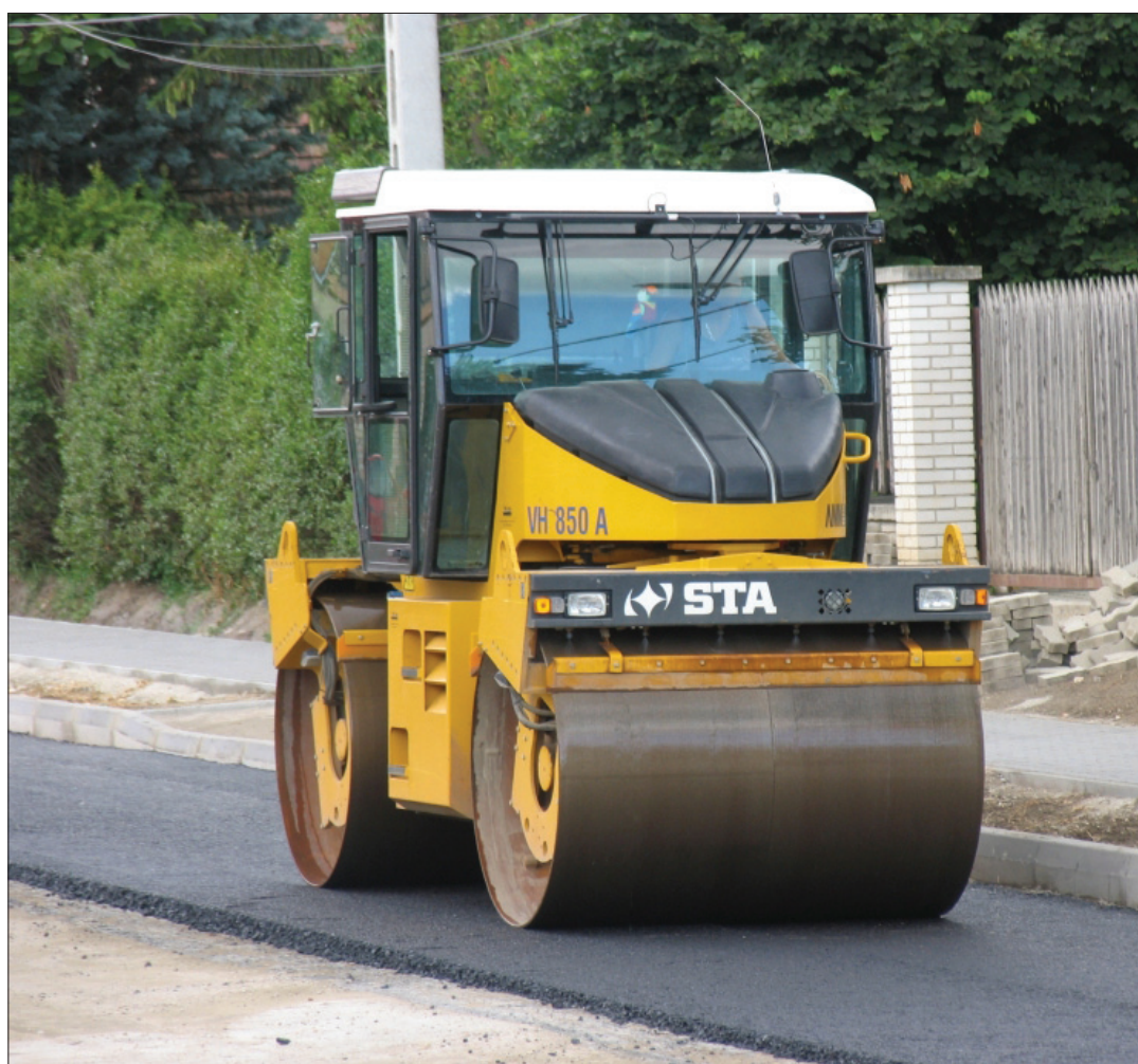
A kerületiek többségét érinti a Pesti út felújítása
