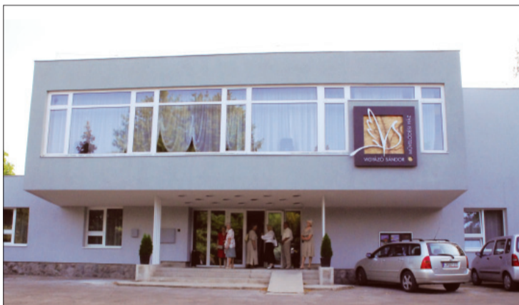
A legnagyobb beruházás a homlokzat és a tető felújítása volt
