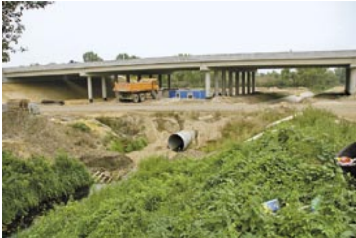
Szakosított duzzasztás az M0-s körgyűrű mentén. A Szilas-pataknak ezt a szintkülönbséget kellene megugrania a továbbjutáshoz
