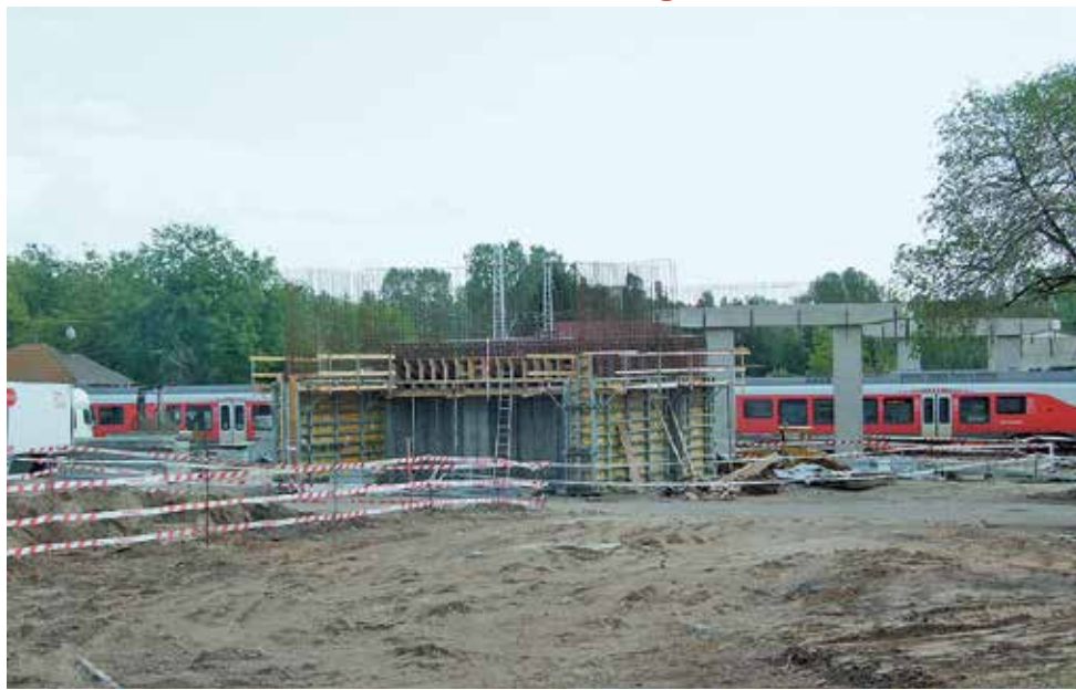
Felvételünk a Cinkotai úti felüljárónál készült, ahol már állnak a közúti felüljáró lábai
