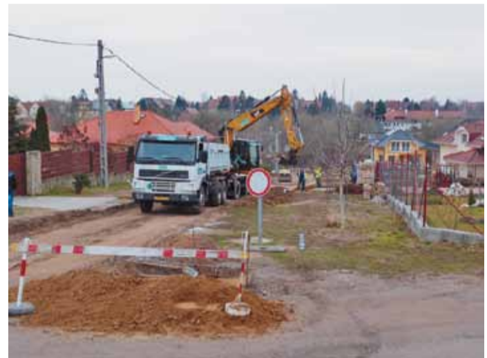
A Majorszegi ligetben márciusban megkezdődött a Csömöri út építése
