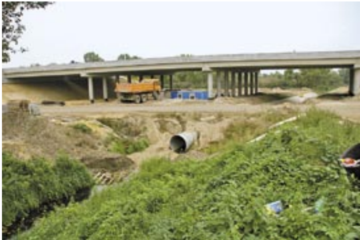
Szakszerű duzzasztás az M0-s körgyűrű mentén. A Szilas-pataknak ezt a szintkülönbséget kellene megugrania a továbbjutáshoz
