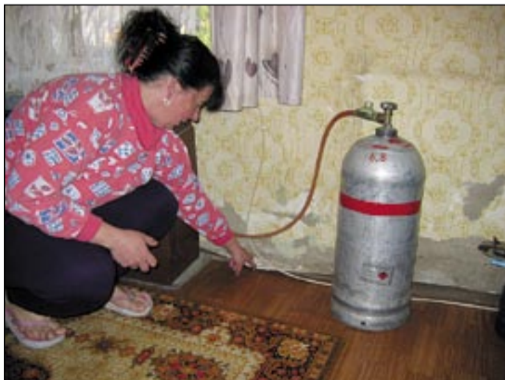
Erdei gomba terem a szegély mellett, a gázpalack tövében
